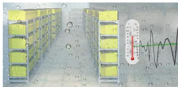
Die Folge von Kondensation in eventuell kontaminierten Räumen (Schwefel, Salzkristalle) erzeugt eine aggressive Atmosphäre und damit Korrosion an allen exponierten Teilen, im Langzeitbetrieb auch an den durch Schutzlack geschützten Teilen. Das führte zum Teil zum Totalausfall der Module und verwendeten Kabel.
