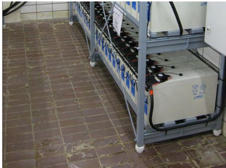
Obwohl der Raum mit Elektrolyten erheblich kontaminiert ist, zeigen die BACS-Module auch nach über 15 Jahren dort im Einsatz keinerlei Korrosionsschäden!
